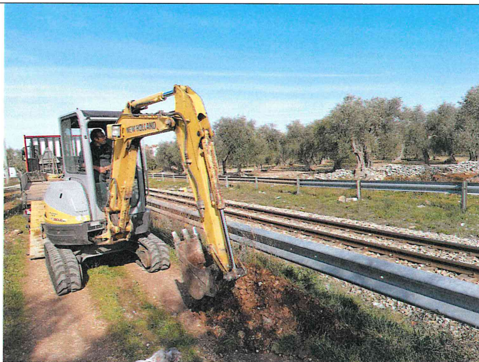
Esecuzione pozzetto geognostico e prelievo dei campioni Ca9 alle diverse profondità
