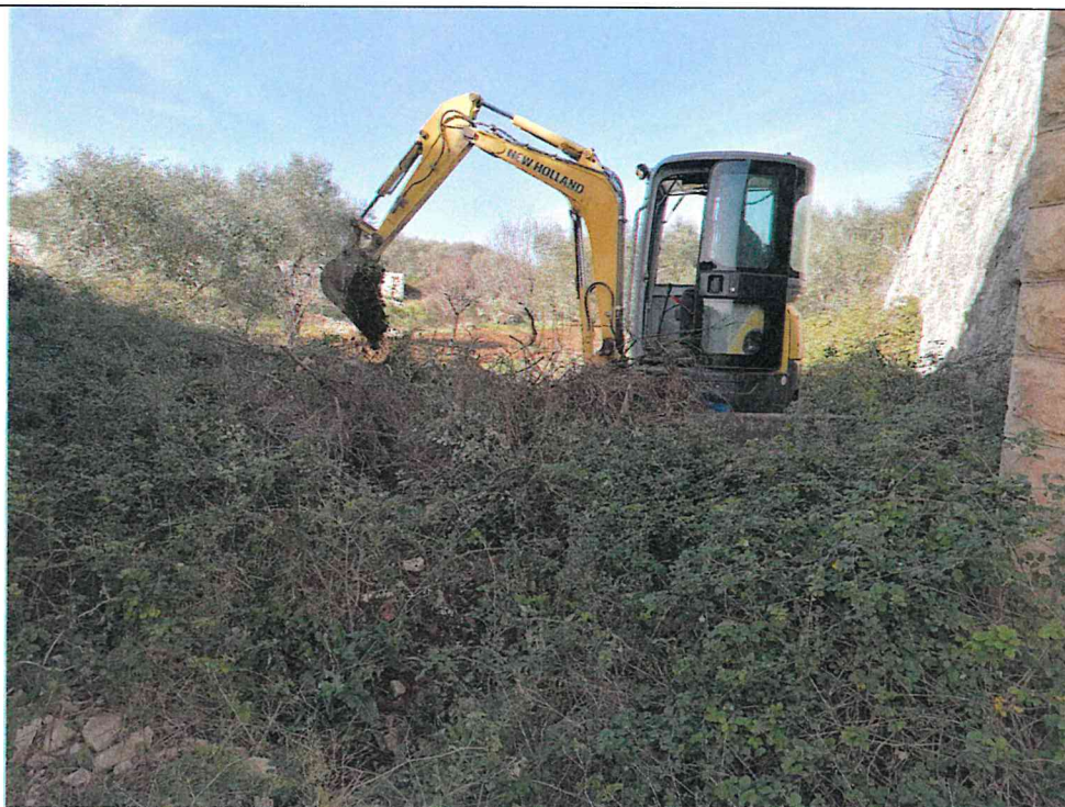
Esecuzione pozzetto geognostico e prelievo dei campioni Ca7 alle diverse profondità
