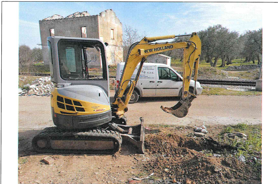
Esecuzione pozzetto geognostico e prelievo dei campioni Ca4 alle diverse profondità
