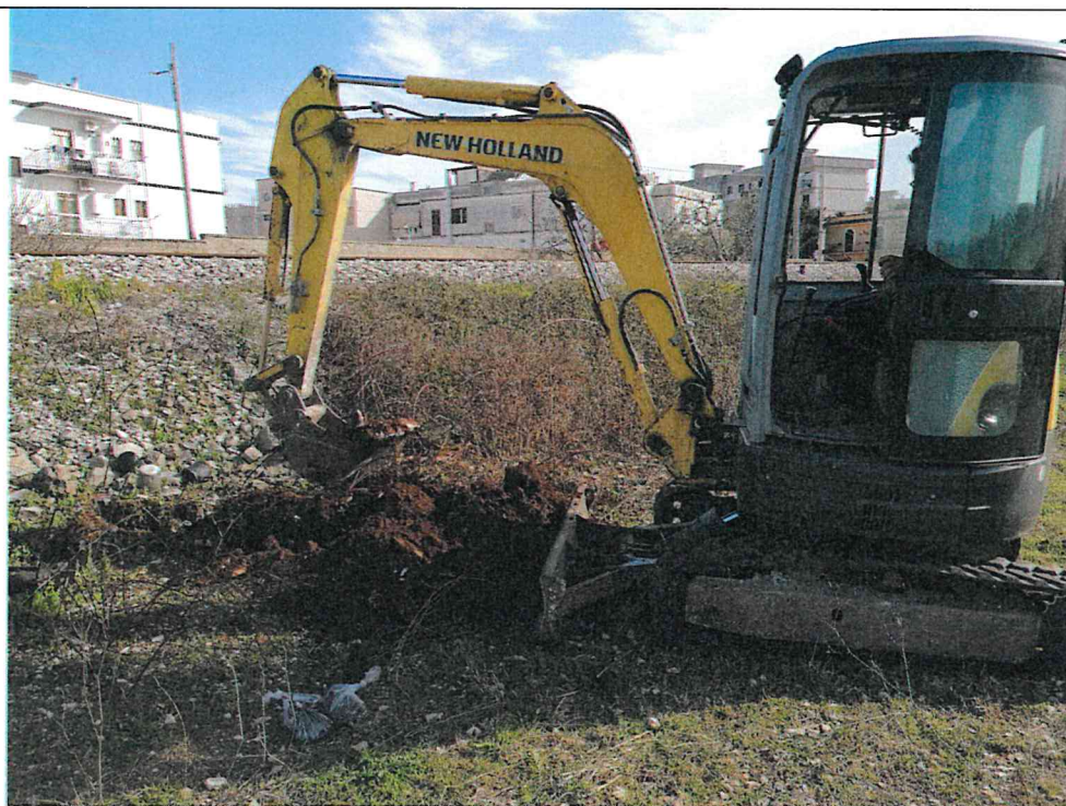
Esecuzione pozzetto geognostico e prelievo dei campioni Ca10 alle diverse profondità
