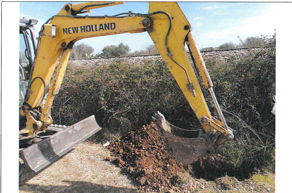
Esecuzione pozzetto geognostico e prelievo dei campioni Ca6 alle diverse profondità
