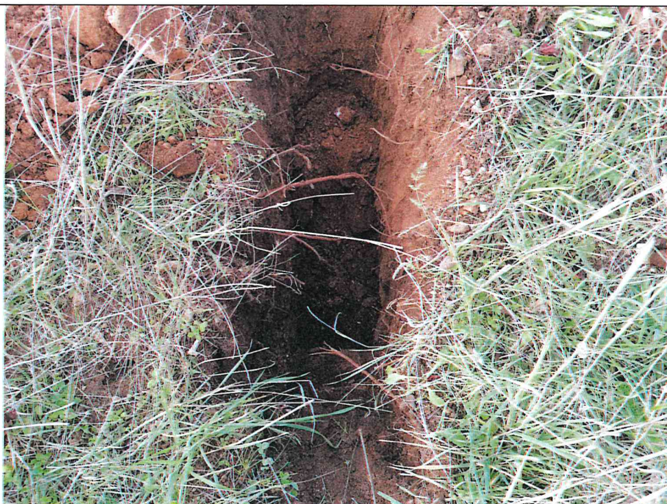
Esecuzione pozzetto geognostico e prelievo dei campioni Ca2 alle diverse profondità
