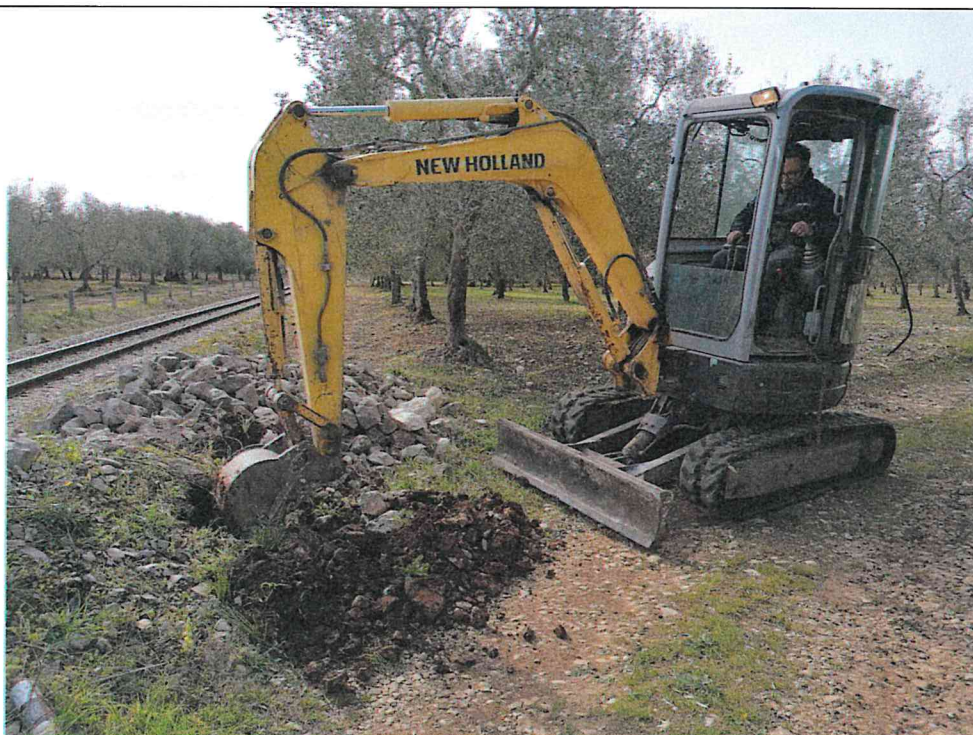
Esecuzione pozzetto geognostico e prelievo dei campioni Ca3 alle diverse profondità
