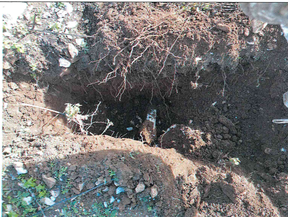
Esecuzione pozzetto geognostico e prelievo dei campioni Ca10 alle diverse profondità
