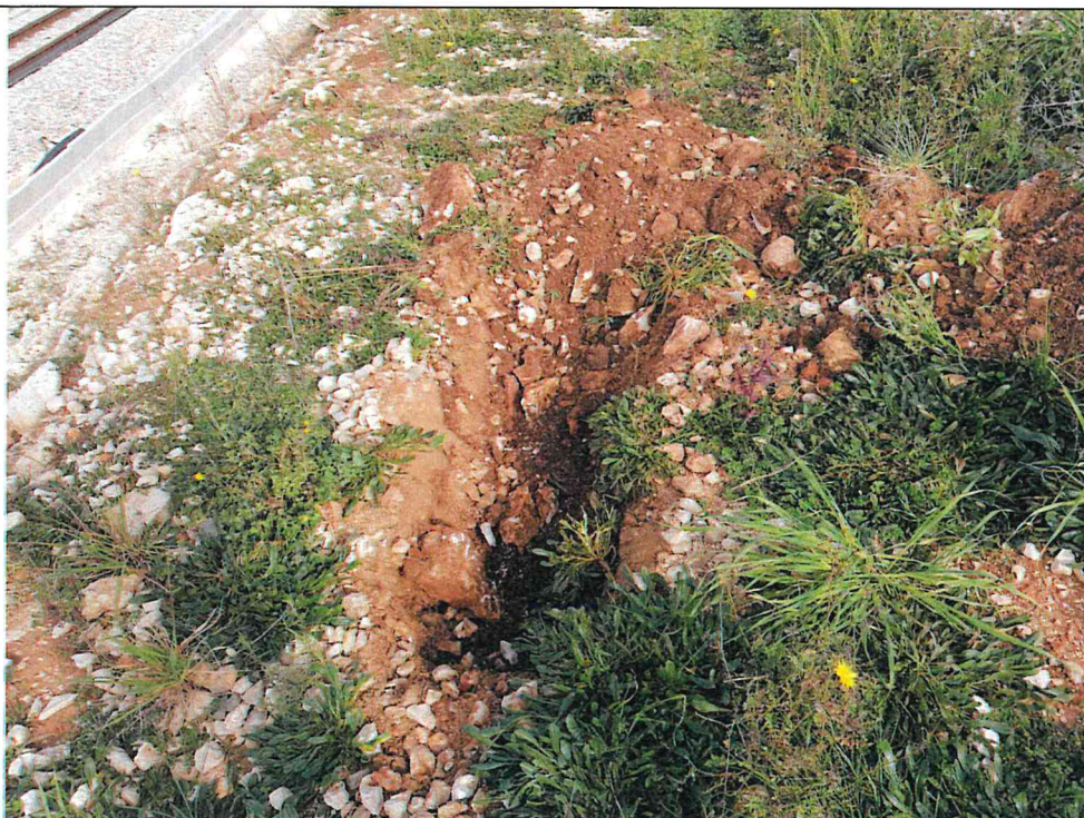
Esecuzione pozzetto geognostico e prelievo dei campioni Ca1 alle diverse profondità
