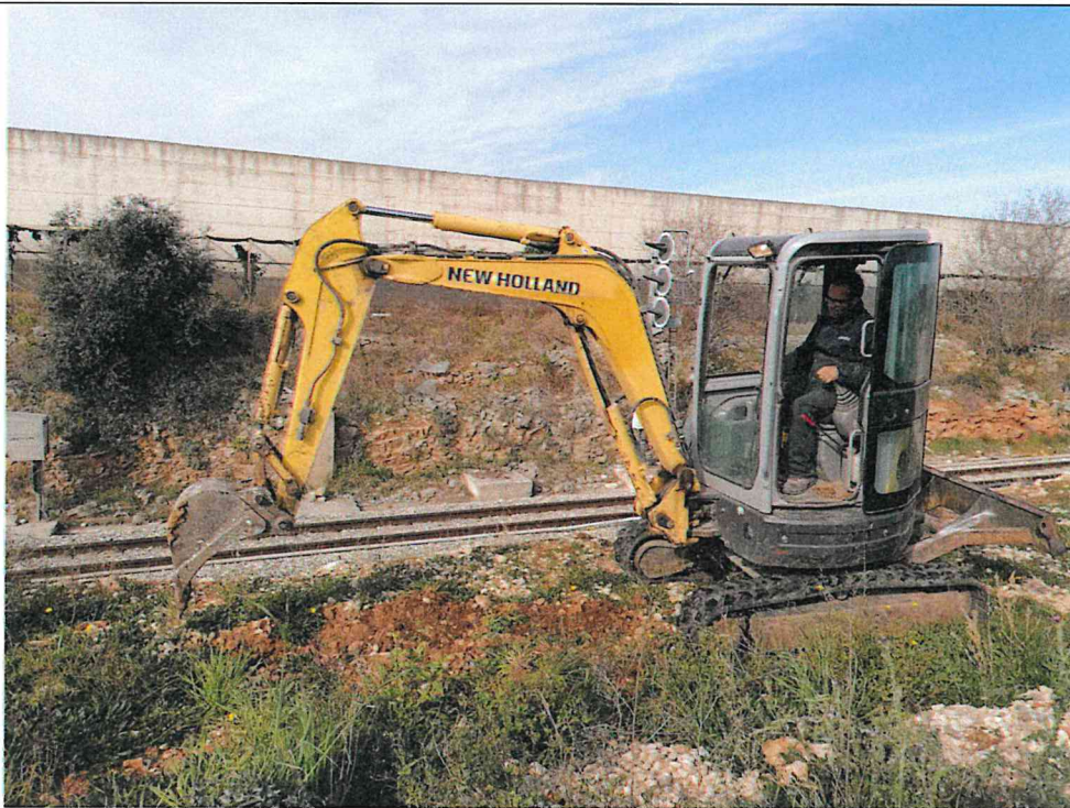
Esecuzione pozzetto geognostico e prelievo dei campioni Ca1 alle diverse profondità
