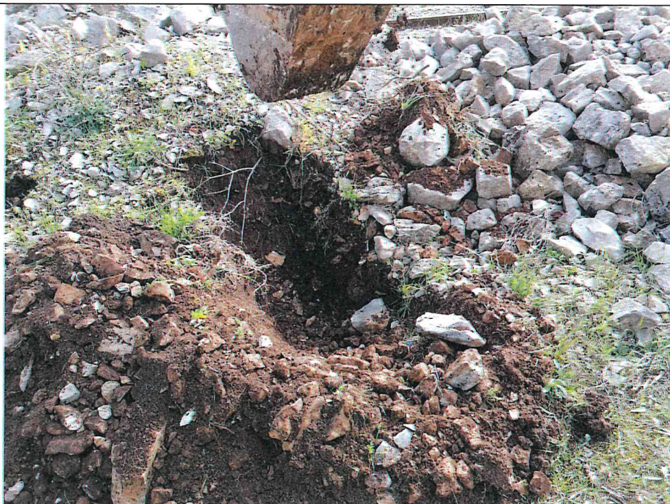
Esecuzione pozzetto geognostico e prelievo dei campioni Ca3 alle diverse profondità
